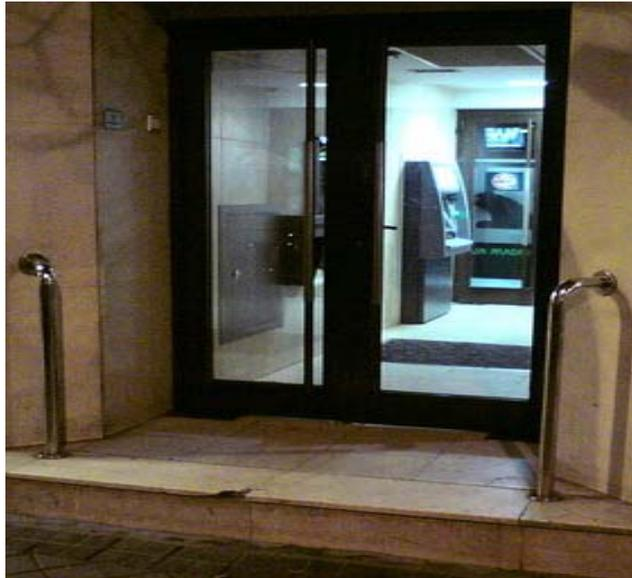
**Figura 3. Ejemplo de adecuación no efectiva: el cajero está adaptado a usuario de ruedas pero no el acceso**
